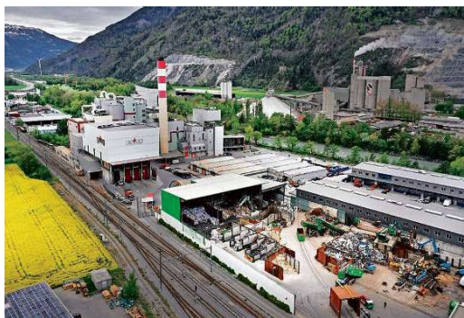
Die Kehrichtverbrennungsanlage Trimmis hat sich innert gut 50 Jahren gewandelt: Die Energieproduktion ist heute ein wichtiger Faktor. (FOTO PHILIPP BAER)
